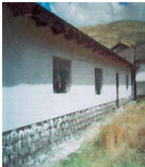
Muro de local comunal rehabilitado de distrito de Yanacancha, año 2007.
