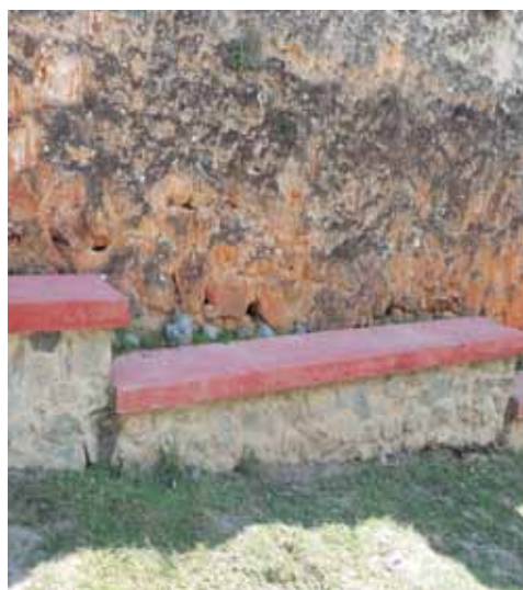
Bancas construidas en exteriores del cementerio distrito de Ulcumayo. Año 2011.
