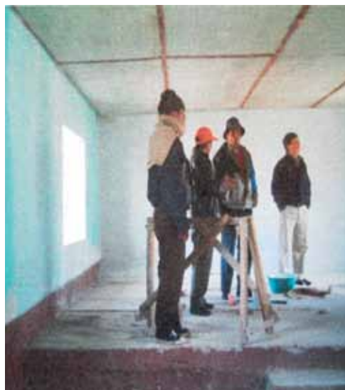
Ingenieros y trabajadores en interior de local comunal con cielo raso sin concluir. Distrito de Yanacancha, año 2007.
